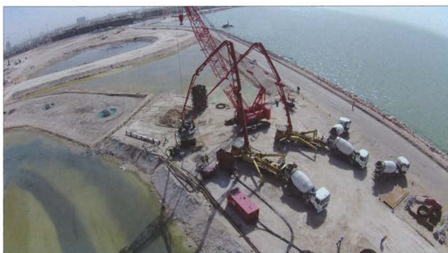
Figura 14: Vista aerea della fase di getto di un palo a terra
