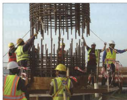
Figura 13: Tubo attrezzato con pedana di lavoro per evitare spargimenti di polimero
