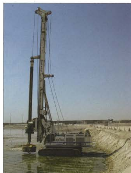
Figura 2: La scelta, per quanto riguarda i mezzi da utilizzare nel progetto, è ricaduta sui modelli SR-100, SC-120 con rotary SA-40 e R-930
