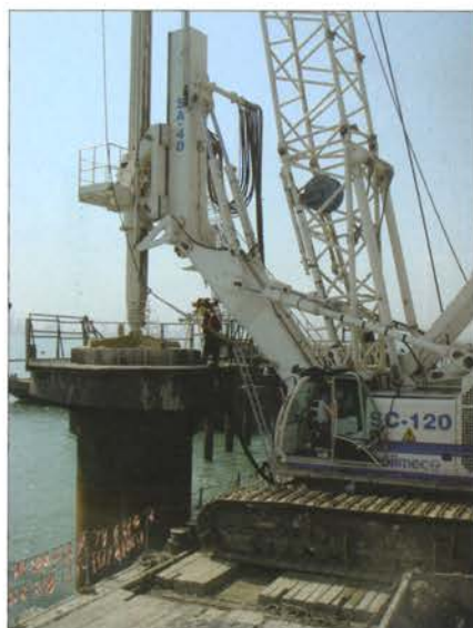
Figura 2: La scelta, per quanto riguarda i mezzi da utilizzare nel progetto, è ricaduta sui modelli SR-100, SC-120 con rotary SA-40 e R-930
