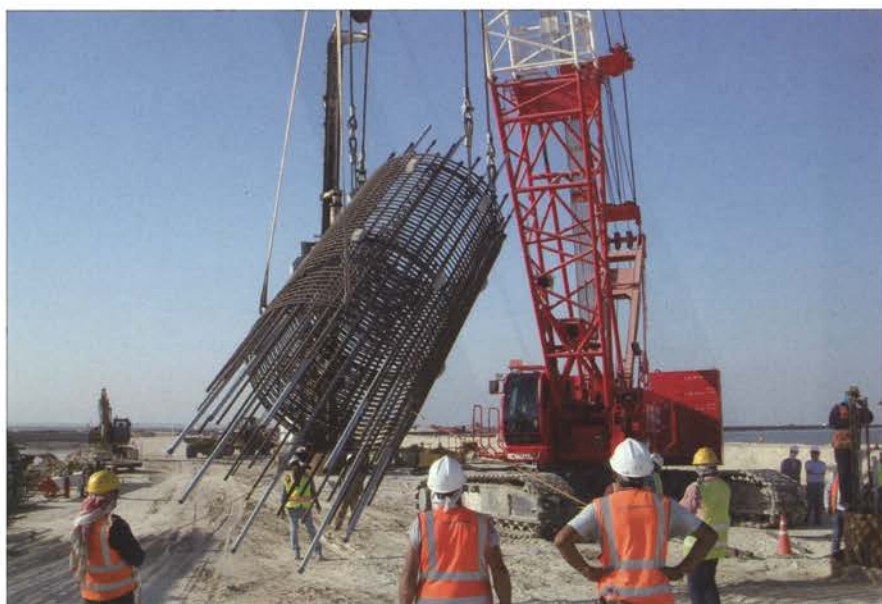
Figura 12: Fasi di sollevamento di uno spezzone di gabbia d'armatura, realizzate utilizzando due gru e appositi bilancieri per evitare di flettere la gabbia in questa fase, con pregiudizio del collegamento a bocca foro con lo spezzone già in opera. Anche per i pali a terra era ovviamente richiesto il collegamento di tutte le barre verticali con dadi filettati
