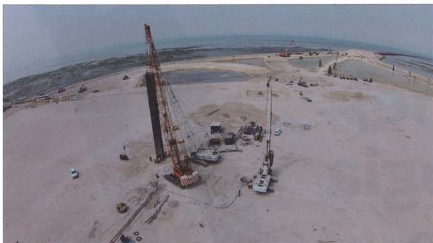
Figura 10: Viste aeree di un'area di cantiere
