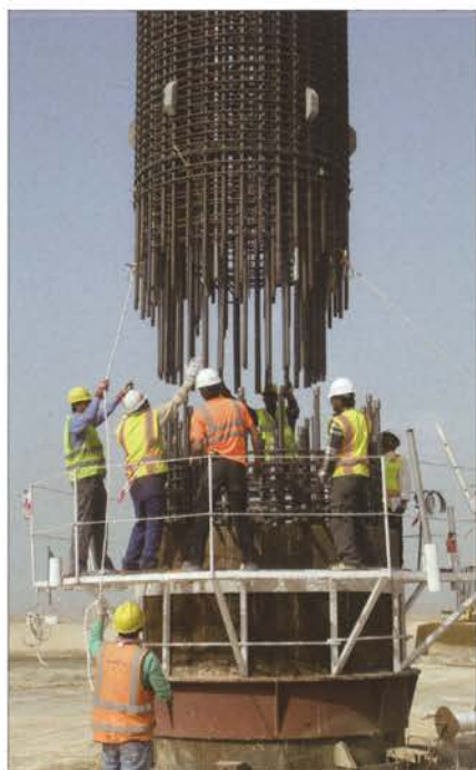
Figura 7: Posa in opera della gabbia di armatura
