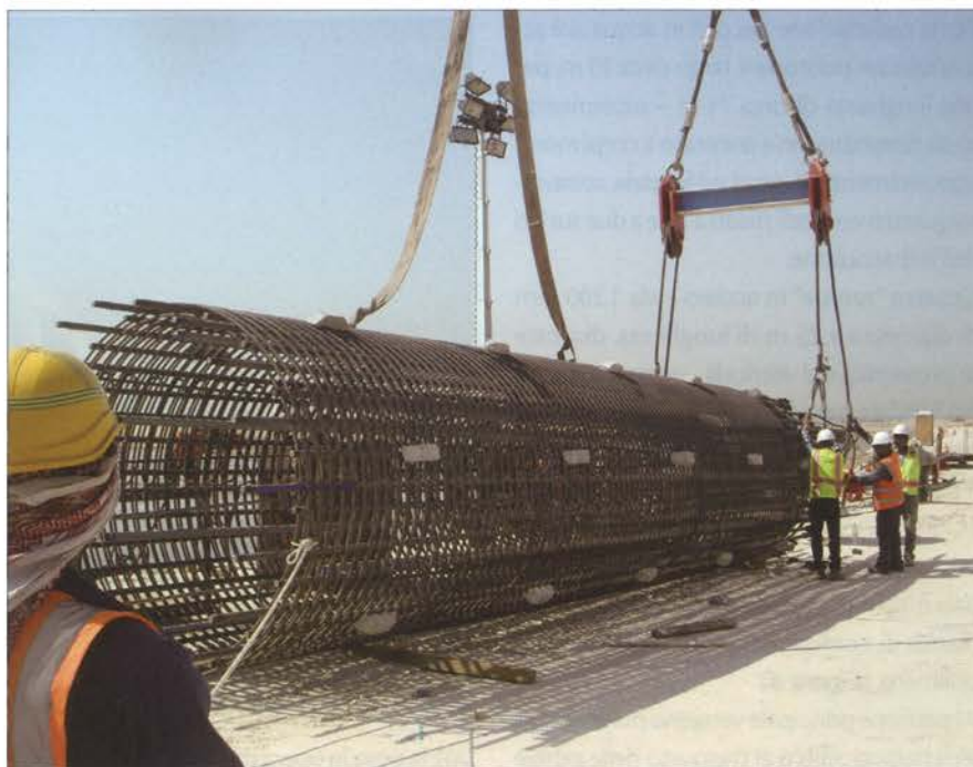
Figura 8: Assemblaggio di un elemento di gabbia di armatura
