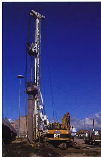
Construction of bored piles using concrete driving coree/Realizzazione di pali trivellati con l'ausilio di coree di guida in CLS armato
