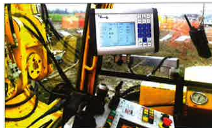
The JET-VISION system is used to measure the parameters of jet-grouting/Il sistema JET-VISION è utilizzato per misurare i parametri di jet-grouting
