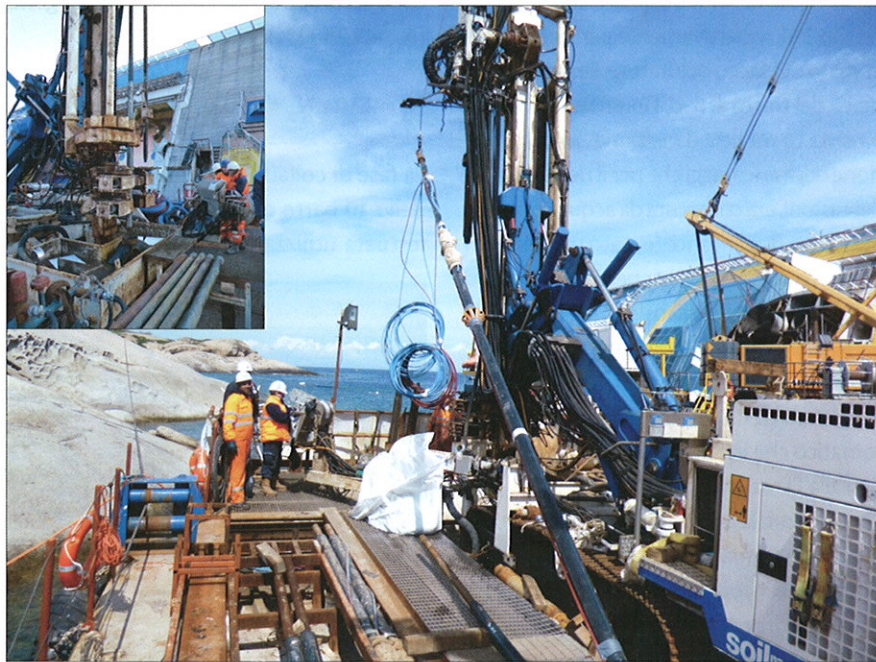
Barre di ancoraggio e relativa installazione
