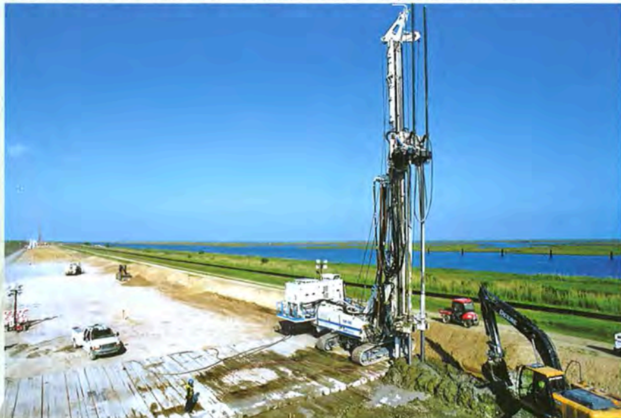
Macchina Soilmec in azione per il consolidamento dell'argine di New Orleans
