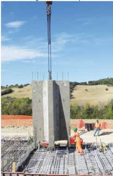
Muro di sostegno con elementi prefabbricati
