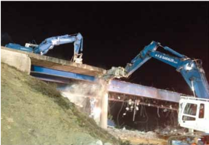
Demolizione cavalcavia esistente
