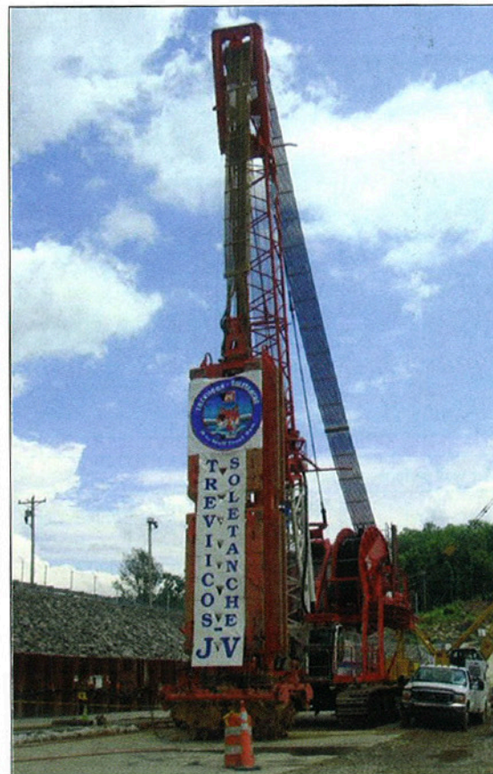
(d) Hydromill set up to work on the CBWM.
