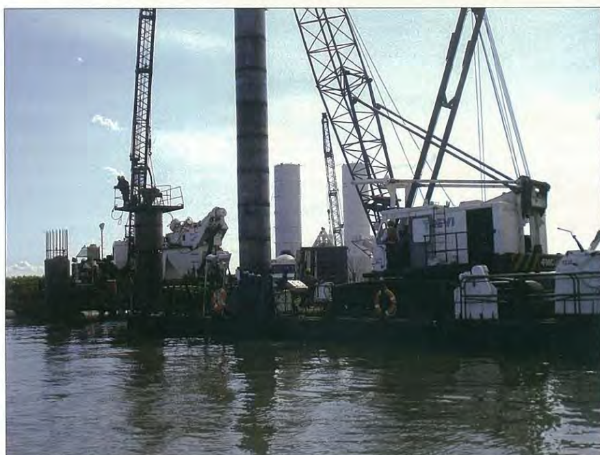
Sul pontone, la Link Belt 338 aggancia la camicia di oltre 10 m
