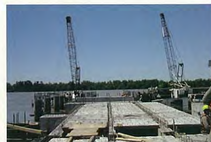
Costruzione del solaio lungo il pontile
