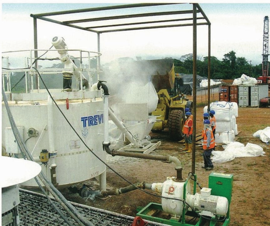
Preparazione in cantiere della miscela plastica auto-indurente Solidur®
