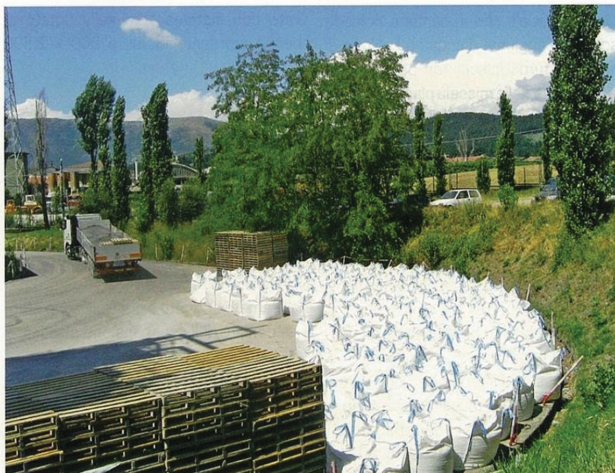
Stoccaggio del premiscelato Solidur® presso il cantiere di Buyo
