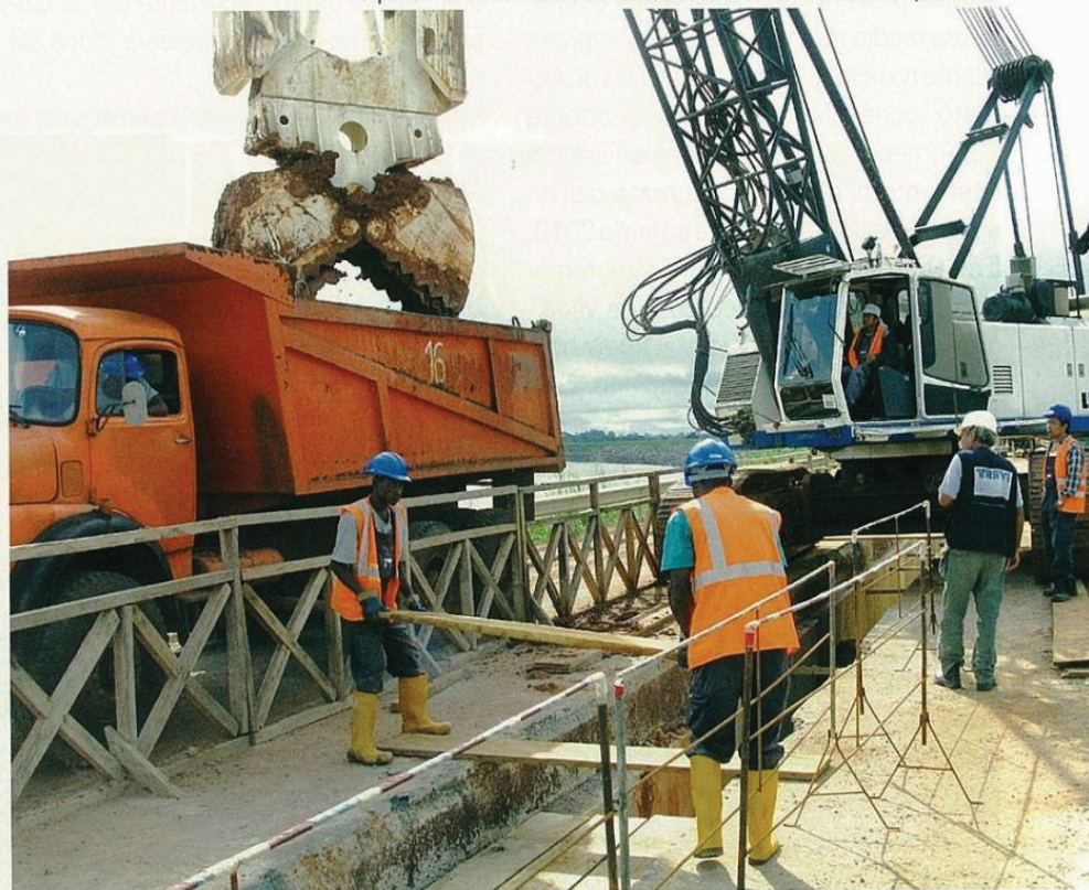
Operazione di scavo e costruzione del diaframma plastico
