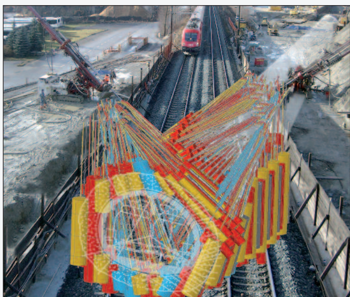
Figura 2 - Il montaggio dello Stans
